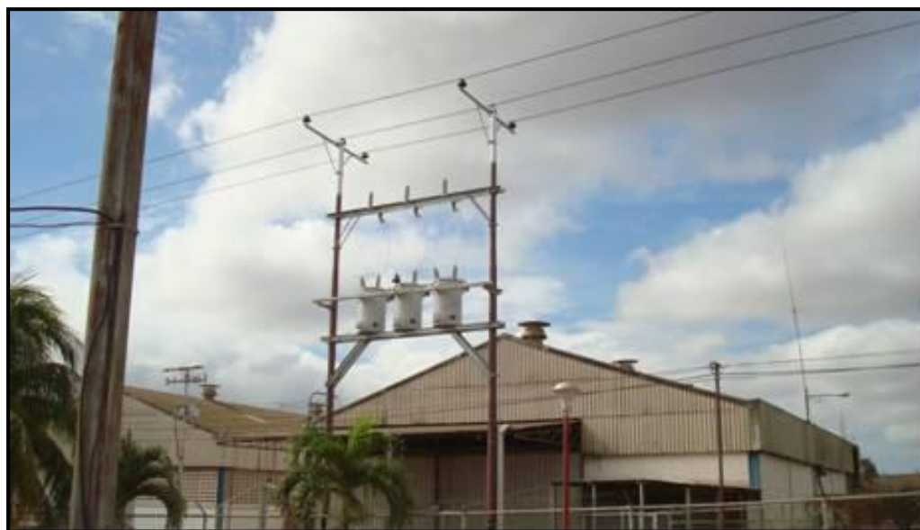
Figura 14.3.- Bancos de transformadores 3x75 kVA en estación tipo H. Planta Chivacoa
