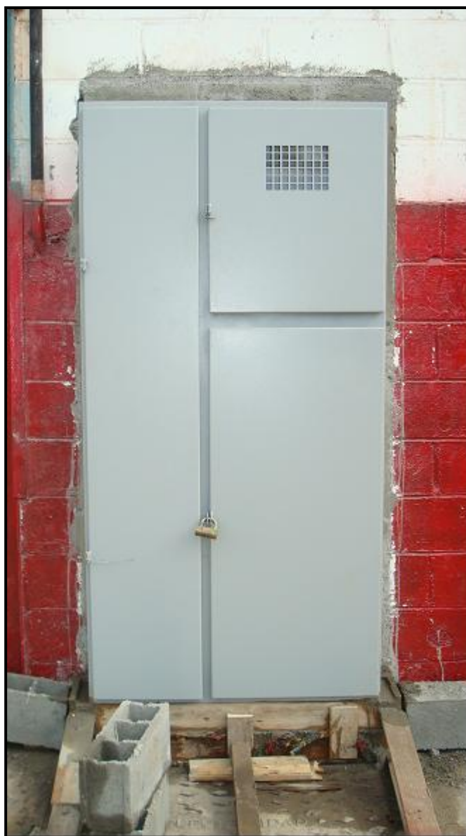
Figura 15.4.- Tablero Eléctrico para las nuevas Granalladoras
