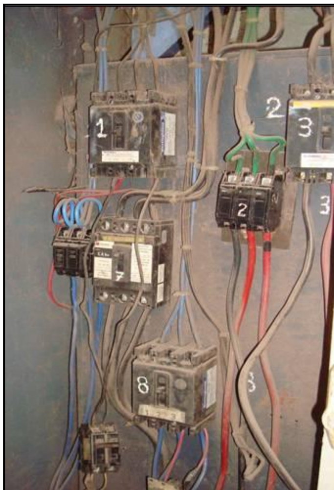
Figura 15.1.- Tablero Principal de Distribución del circuito A de Planta Chivacoa
