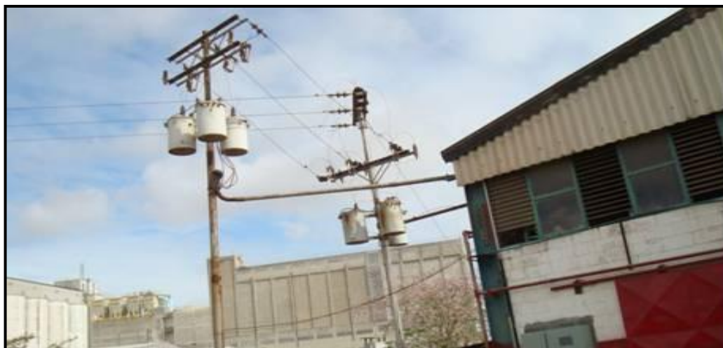
Figura 14.2.- Bancos de transformadores. 3x50 kVA en postes. Planta Chivacoa
